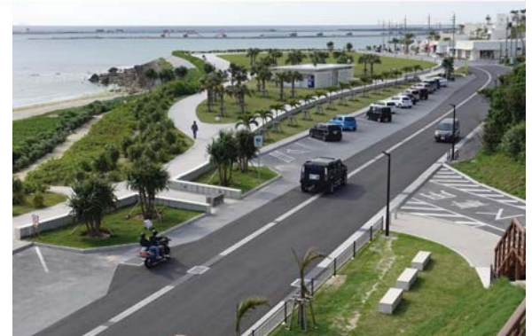
サンセットパークより那覇空港拡張工事を望む
